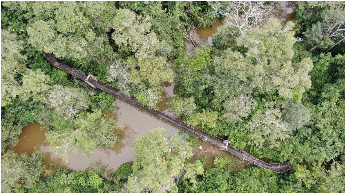
Figura 8 - Vista desde dron del puente colgante 38m de longitud.
