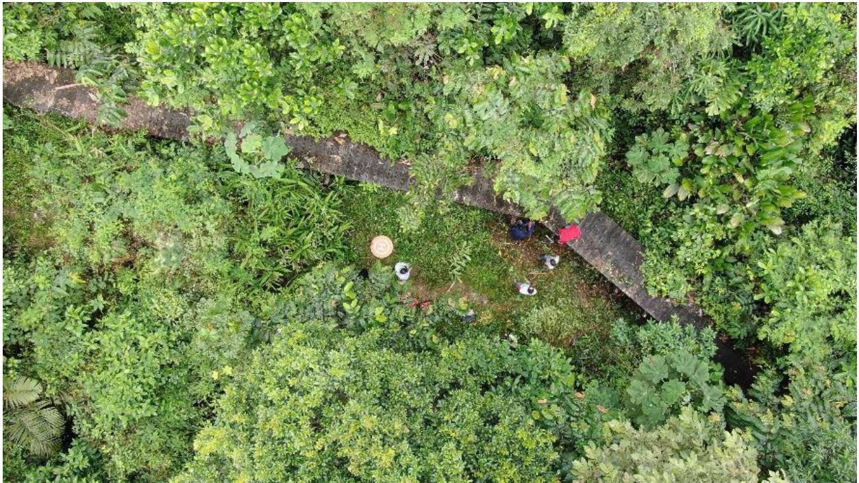
Figura 11 – Vista general del sendero elevado.
