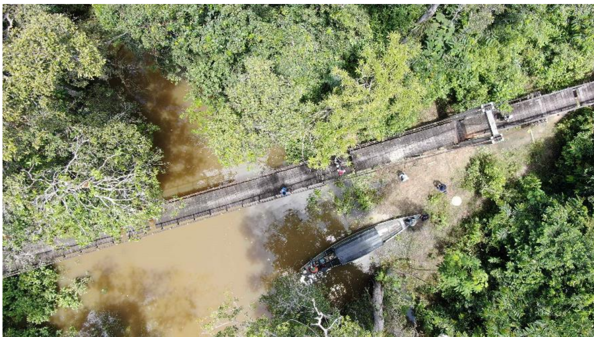
Figura 10 – Vista superior del puente colgante
