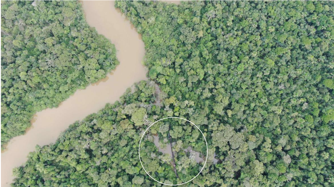
Figura 7 – Vista general de un sector intermedio del sendero, donde se encuentra el puente colgante de 38m de longitud.
